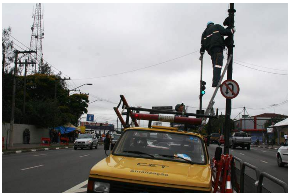
Foto 6 - Equipe de sinalização atuando em emergência semafórica na Operação F1
